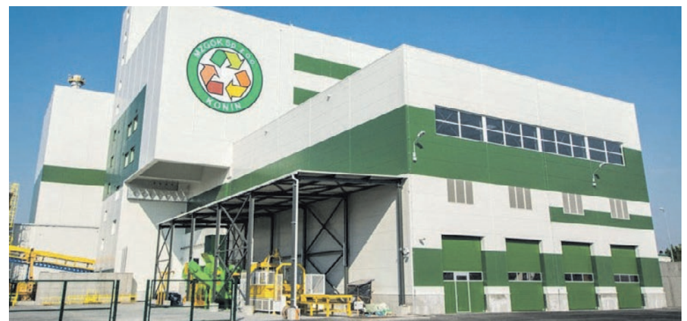
Jedną z instalacji do termicznej utylizacji odpadów znajduje się w Koninie (74 tys. mieszkańców). To stosunkowo małe i niezbyt zamożne miasto, a jednak poradziło sobie z tym wyzwaniem.
