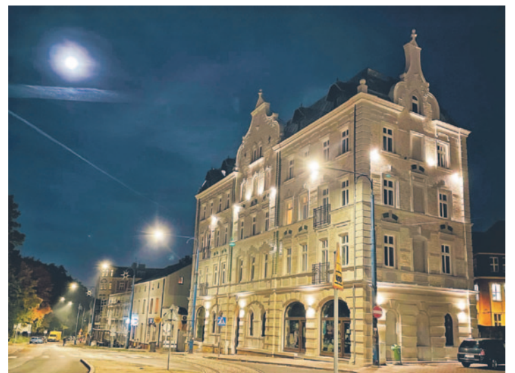
Milion złotych kosztował remont elewacji kamienicy przy Bytomskiej 37.
