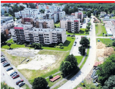
Ruszył remont Kryształowej.
